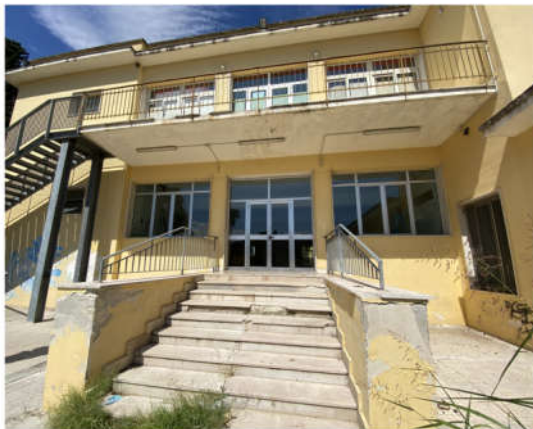
G.R.2.1: SOSTITUZIONE MARMÌ
